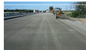
Herstellen der Waschbetonoberfläche
