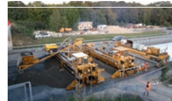
drei Arbeitsstufen bis zur Betonpiste
