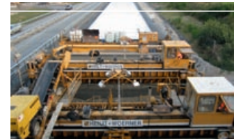
Betonfertiger – Betonieren in einem Rutsch
