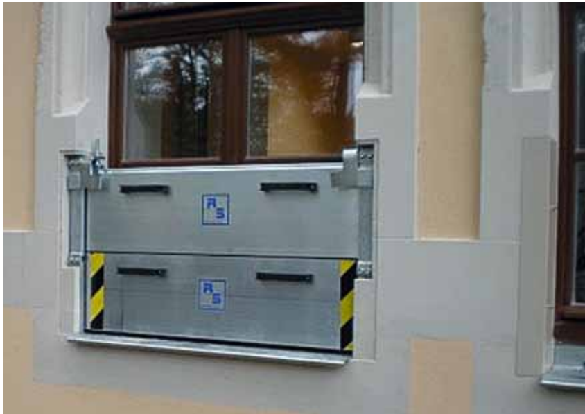
Hochwassersicherung von Fensteröffnungen
