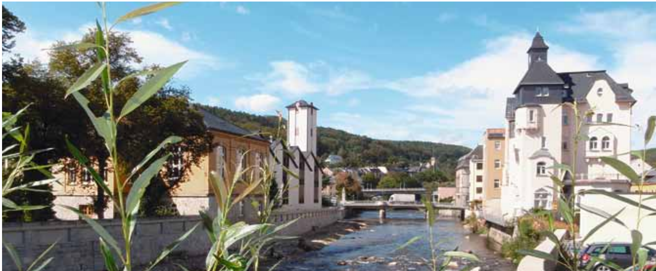
Hochwasserschutzmaßnahme in Aue
