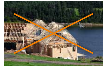
Neubau am Gewässer
