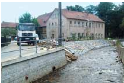
Anlegen einer Böschung statt der zerstörten Mauer an der Lausur
