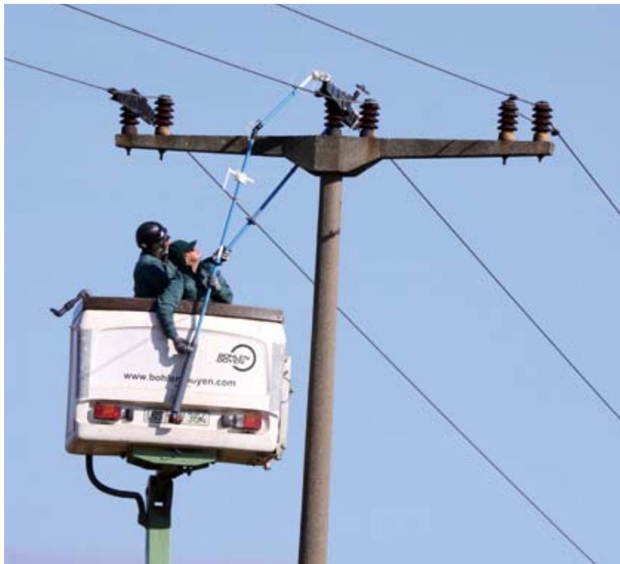
Abb. 12: Es besteht die gesetzliche Aufgabe, Leitungsmasten gegen Stromtod von Vögeln zu sichern. Davon profitieren insbesondere Großvogelarten wie der Kolkrahe. Foto: Archiv Naturschutz LfULG, H. Trapp
