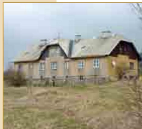
Das Wohngebäude wurde 1908 als Schützenhaus in Ziegelbauweise mit Natursteinsockel errichtet. In den 50er-Jahren erfolgte der Umbau zum Wohnhaus. Seit dieser Zeit sind keine wesentlichen Sanierungsarbeiten durchgeführt worden. Dementsprechend war der Zustand des Gebäudes: Einzelofenheizung, aufsteigende Feuchtigkeit, Asbestschieferdach, das sich langsam auflöste, keine Dachrinnen, einfachverglaste Holzfenster, einfache Sanitäreinrichtung mit zwei Fäkaligruben etc. .
