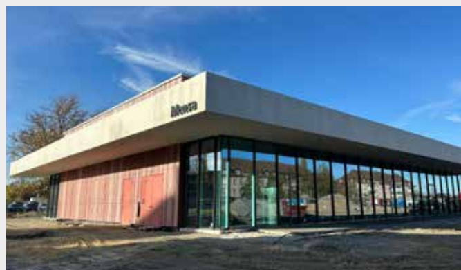
Eines der großen Bauprojekte im Berichtszeitraum: die nahezu fertiggestellte neue Mensa am Campus Bautzen.
