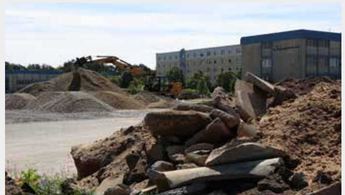
Am Campus Rothenburg wurde im Berichtszeitraum viel gebaut. Hier entsteht das Baufeld für einen dritten Parkplatz.
