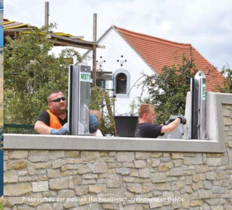
Probeaufbau der mobilen Hochwasserschutz Elemente in Gohlis
