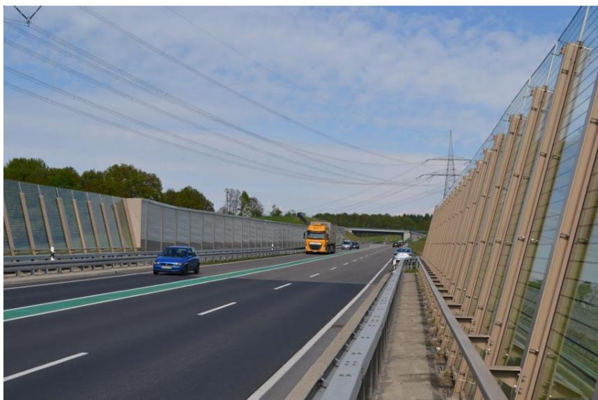
Abbildung 43: Staatsstraße S 177 südlich Pirna, Brückenbauwerk 10 über den Bonnewitzer Grund mit Lärmschutzeinrichtung
